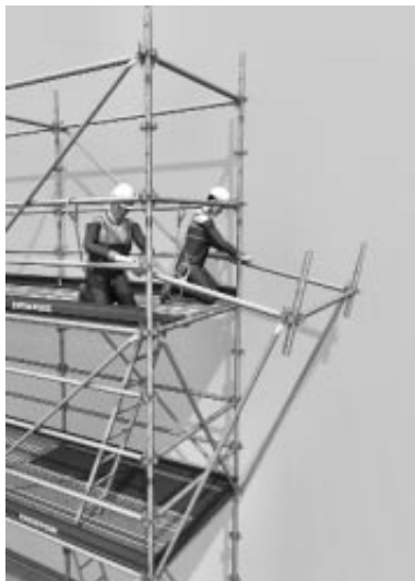
Mise en place des 2 diagonales aux nœuds inférieurs. Lancement du porte-à-faux.
