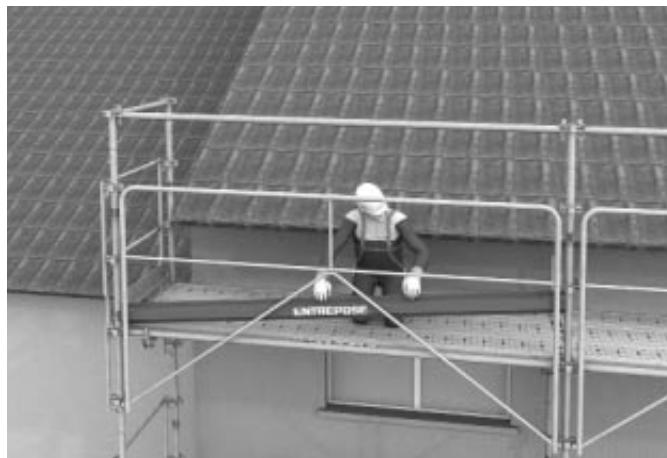
2 Mise en place des goupilles de jonction des poteaux. Mise en place des plinthes.
