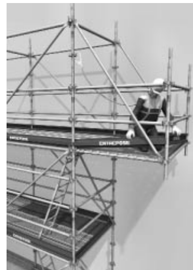
Mise en place des planchers dans le sens de la largeur, puis des montants, des gardes-corps et des plinthes.
