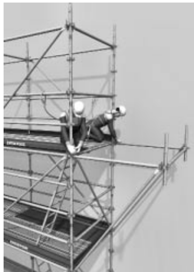
Clavetage des moises au niveau du plancher.
