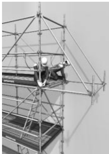
Clavetage des moises au niveau du plancher.
