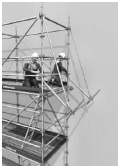
Mise en place des 2 diagonales aux nœuds supérieurs. Lancement du porte-à-faux.
