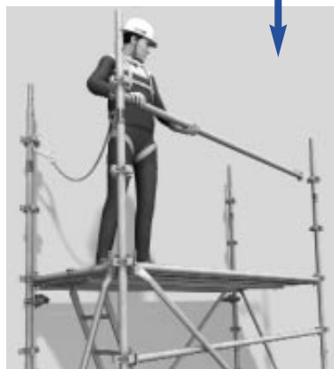
Utilisation d'un système d'arrêt de chute
