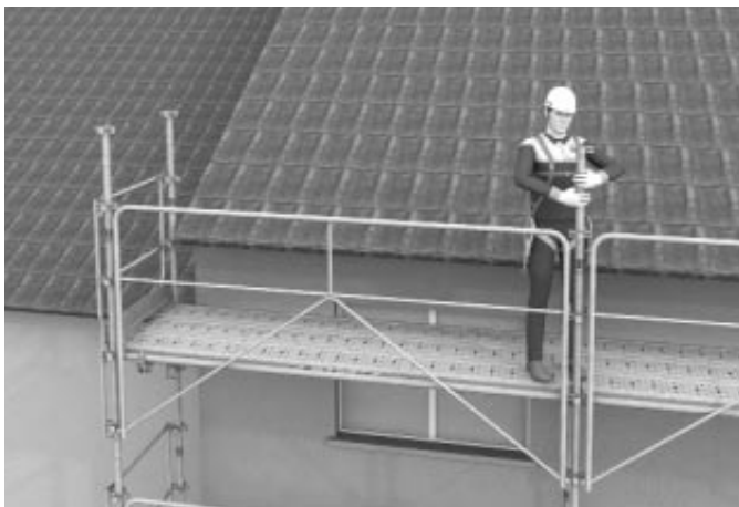
1 Mise en place d'un ancrage sous le plancher par file de poteaux. Réhausse du dernier garde-corps par la mise en place de l'embout de 0,27 m, pour permettre la fixation du dispositif de protection.
